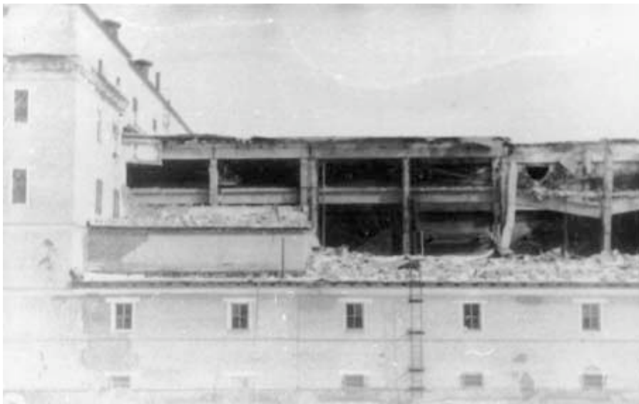
Figure 4. Vue du bâtiment de Tomsk-7 après l'explosion de red oil en 1993
