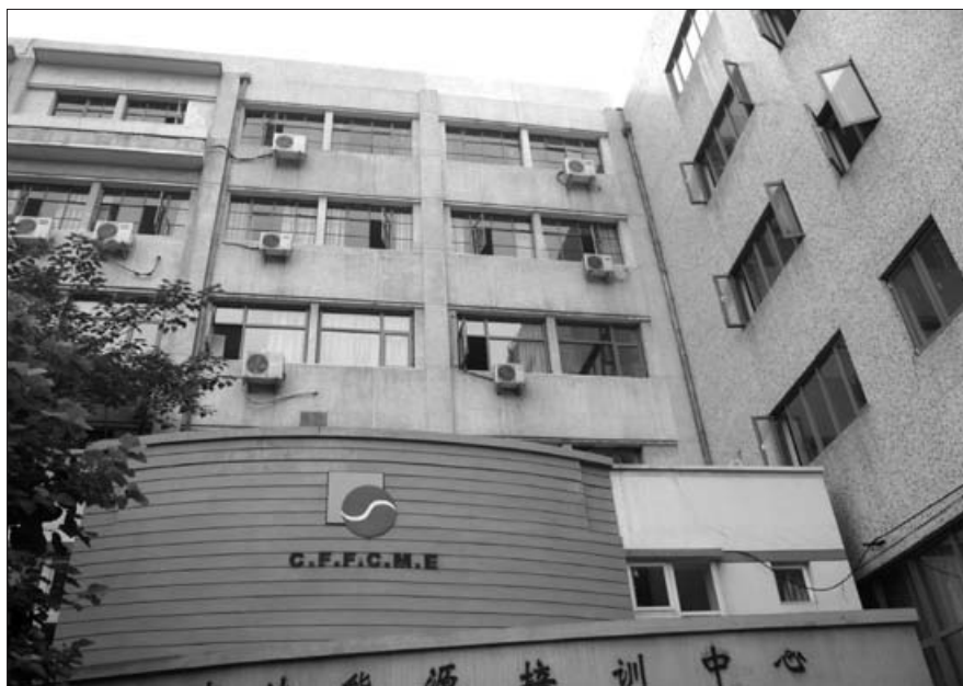
Le CFFCME après réhabilitation. (photos Michel Raoust)
