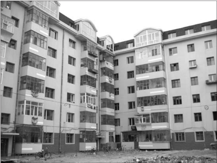
Bâtiment de Harbin après réhabilitation (photo Michel Raoust)
