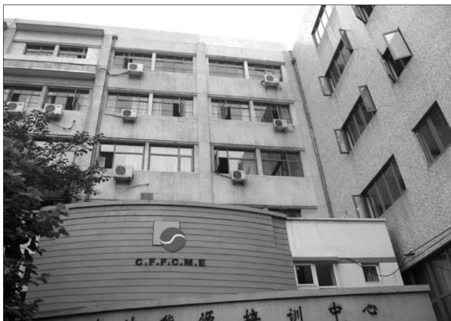
Le CFFCME après réhabilitation. (photos Michel Raoust)
