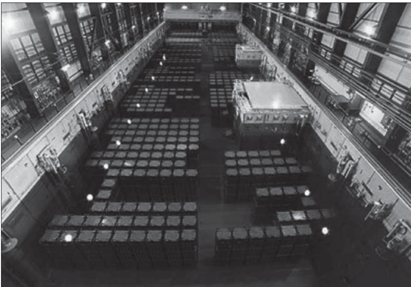
Figure 1 : Vue d'une piscine de l'usine UP3
