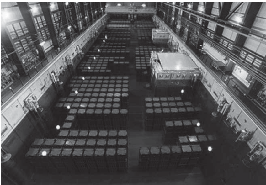
Figure 1 : Vue d'une piscine de l'usine UP3
