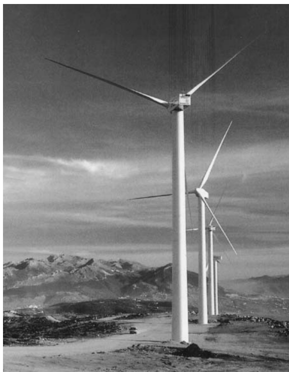
Parc éolien de la cimenterie Lafarge, 10,2 MW
